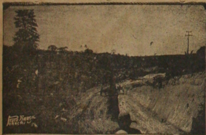
Estrada em construção de Laranjeiras a Socorro — boas rectas, optimas curvas, rampas suaves
