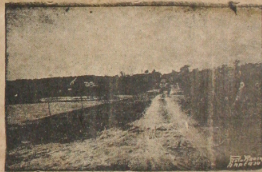
Estrada em construção de Laranjeiras a Socorro com oito metros de largura
