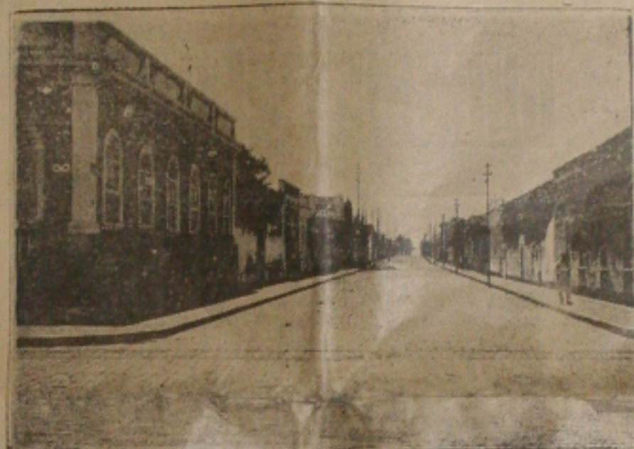
Rua de Maroim — Calçamento (1929)
