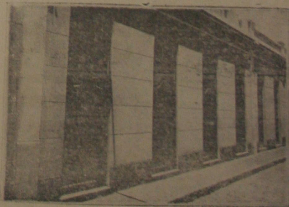
Travessa Municipal - Fachada das instalações sanitárias (1929)
