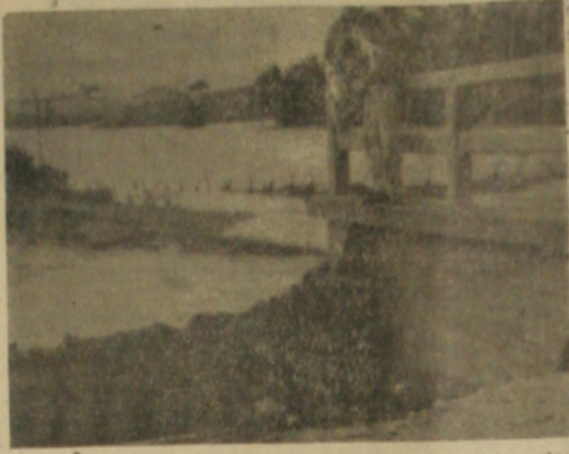
Banca da ponte sobre o rio Sergipe foi arrastada pelas águas
