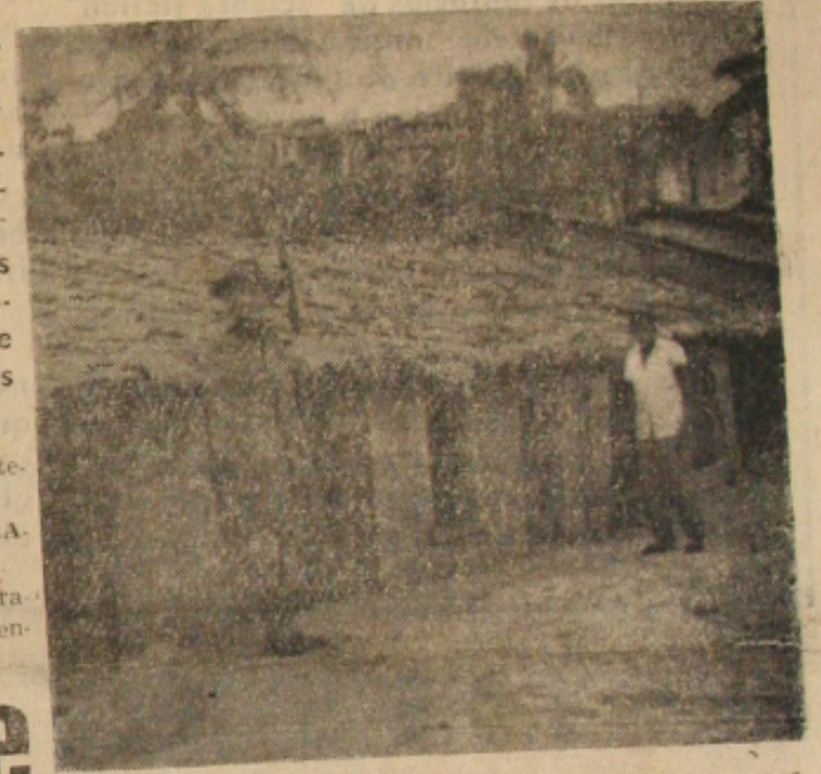
Casas soterradas na rua Propriá
