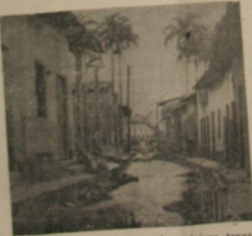
A rua Gangaleixo, em Laranjeiras, transformou-se numa via de aspectos, com suas casas tendo somente as fachadas. Em seu leito corria um volume d'água superior a qualquer riocho.
