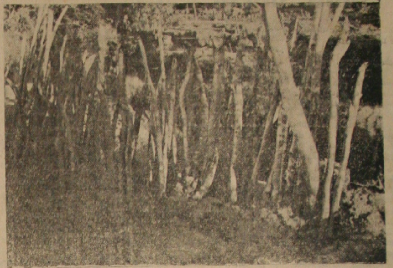
Essa barragem de pau e pique é uma improvisação dos operários dos SASEA na «Cabrita», para a partir que água do charco vá para o Pitanga. Como essa existem outras segundas águas das poças para o abastecimento de Aracaju. Note-se as poças que fornecem a água.
