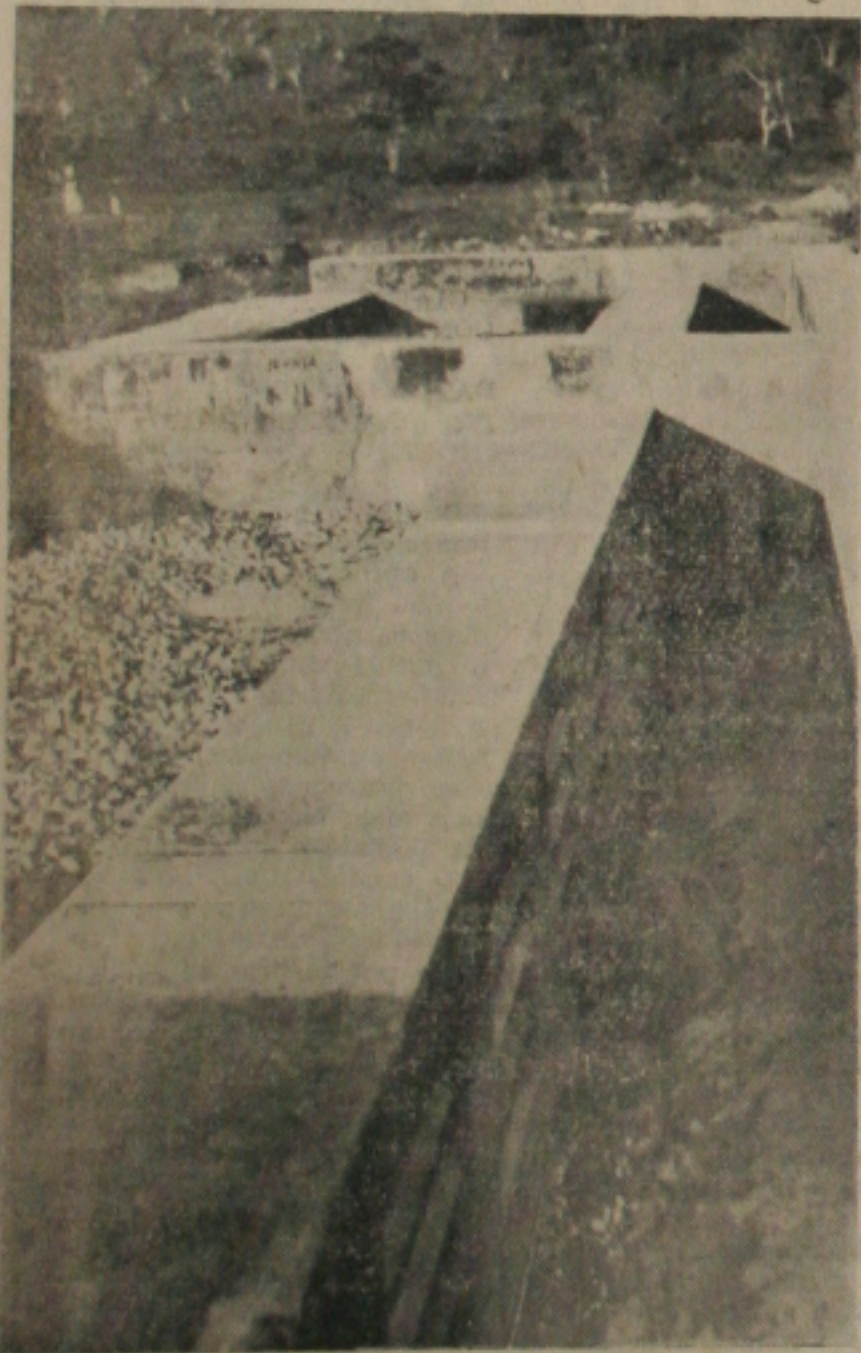
Este é o antigo filtro da barragem, hoje completamente abandonada e sem nenhuma utilidade. Aqui, nos tempos da "Cabrita", antes do Governo Luiz Garcia, ficava o grosso dos detritos e das impurezas da água.
