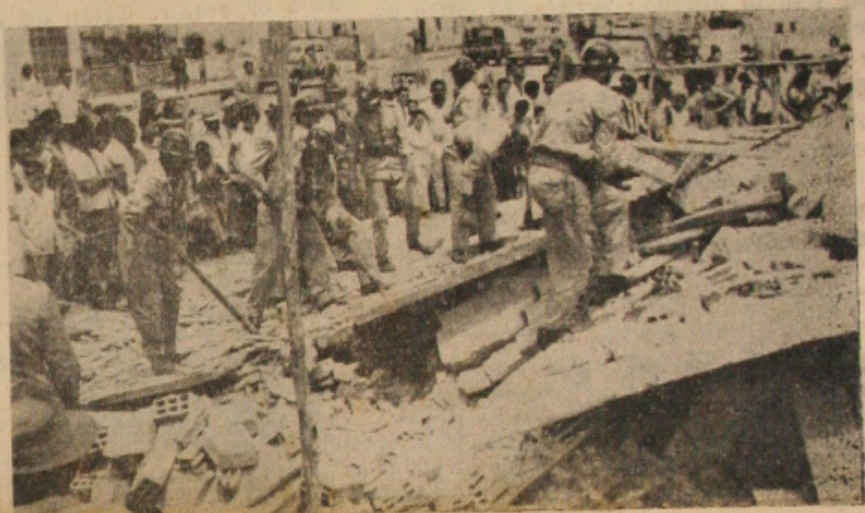
Aspecto do desabamento de ontem na Praça Godofredo Diniz
