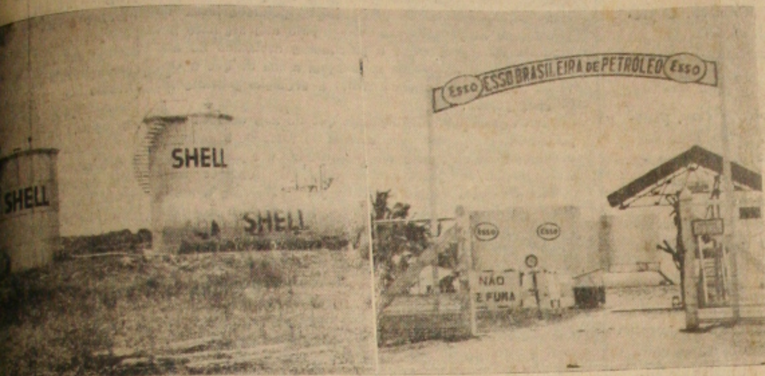
Depósitos insuficientes da Esso e os abandonados da Shell
