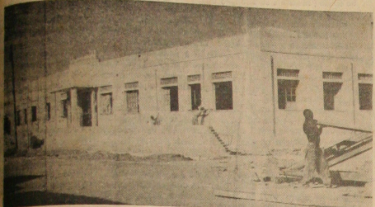
"Colégio do Município" cuja construção deverá estar concluída a 31 de janeiro.
