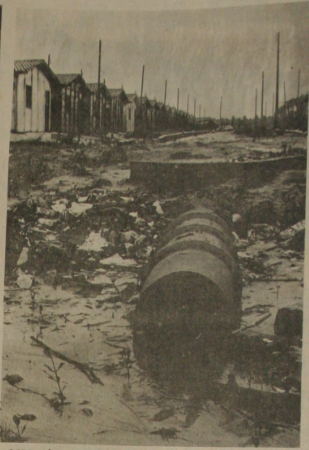
...e os esgotos entupidos.
