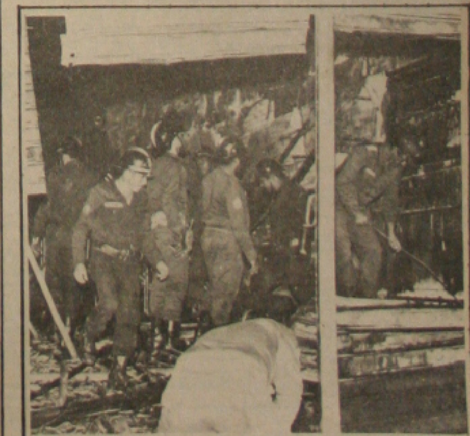
Bombeiros trabalham na Loja "Inês Center", totalmente destruída.
