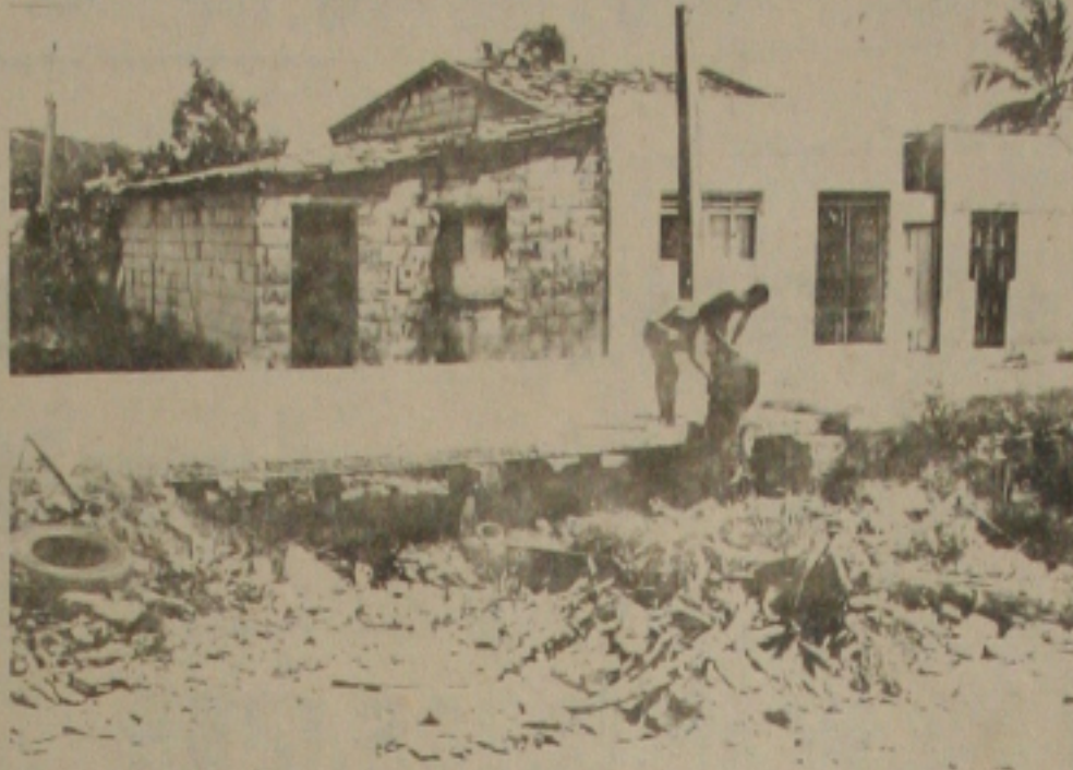
O canal que corta a rua José Conrado de Araújo está total-mente tomado pelo lixo, amea-çando a saúde pública.
