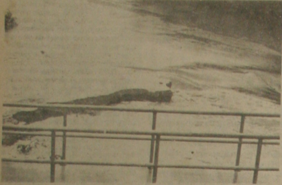
Nas Estação de Tratamento do Deso, as águas provocaram muitos danos.
