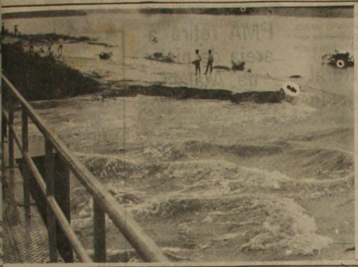
Barragem do Rio Poxim rompeu, inundando Conjuntos e bairros na Leste.
