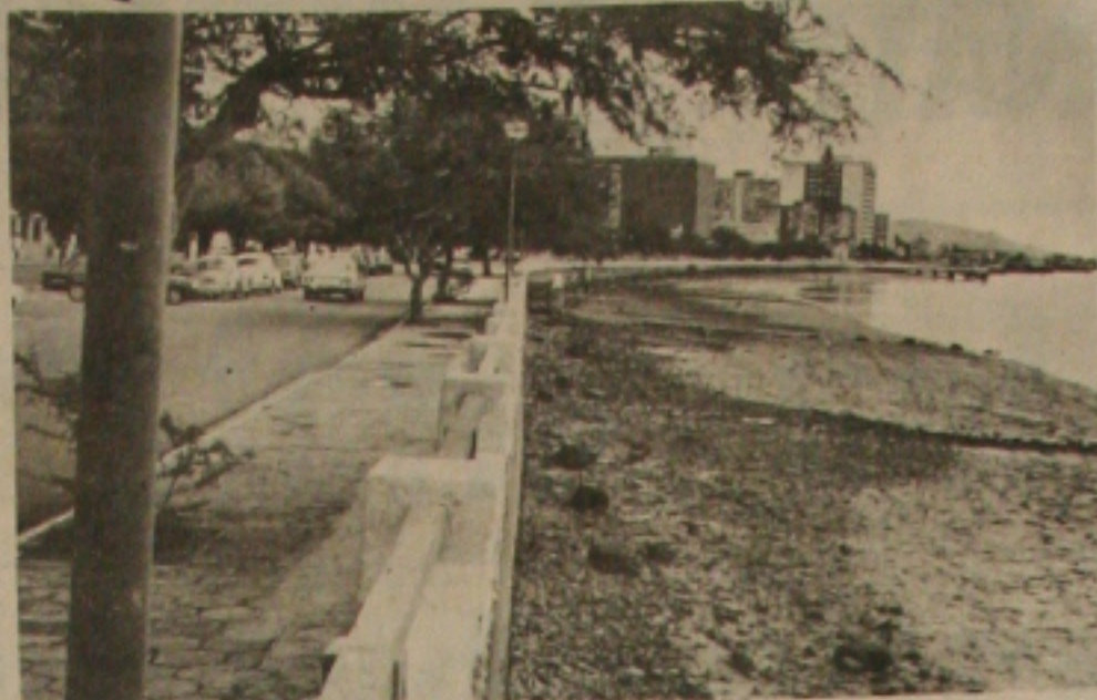
O estacionamento ocupará toda essa extensão da orla marítima.
