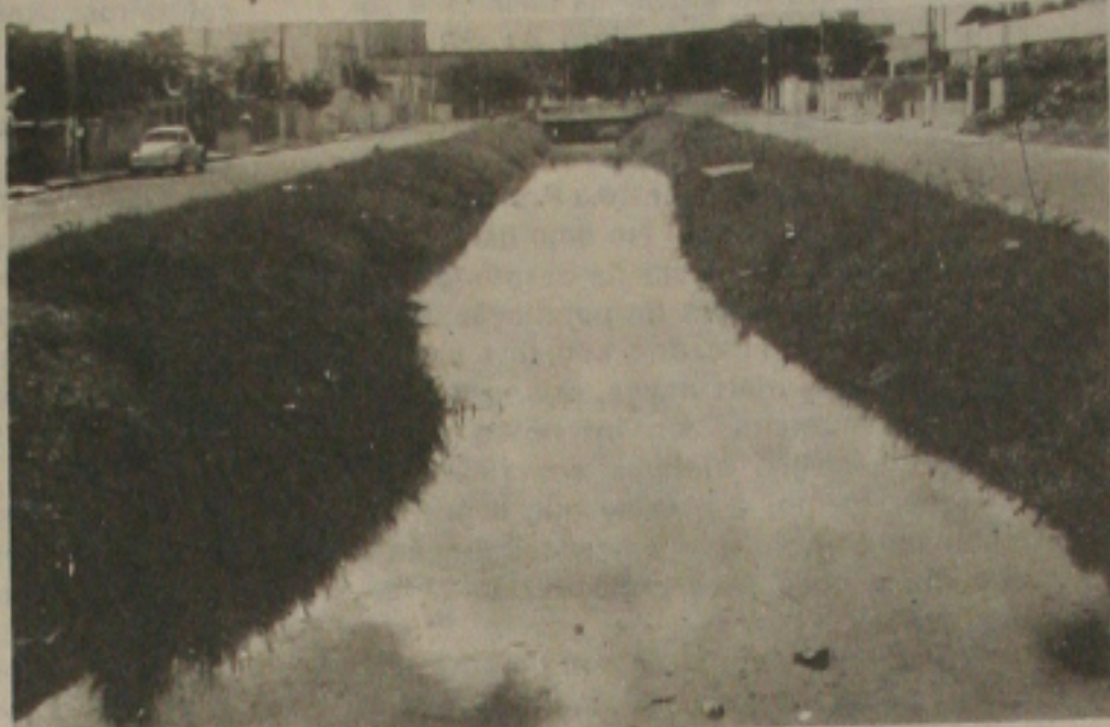
O Canal Gonçalo Prado está entre os que serão revestidos.
