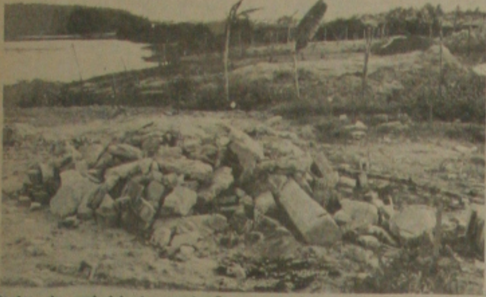
Restos de material de construção que servem para o aterro...
