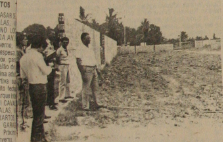
futuro Estádio "Gavião", em construção na Colônia Treze.
