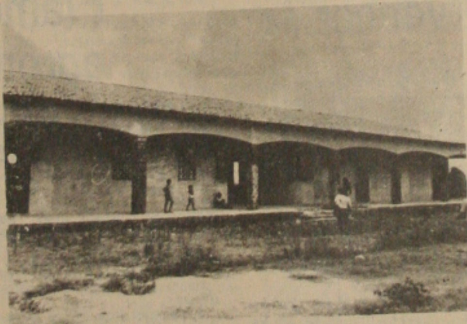
Na antiga estação da RFFSA futuramente funcionará uma creche Escola.
