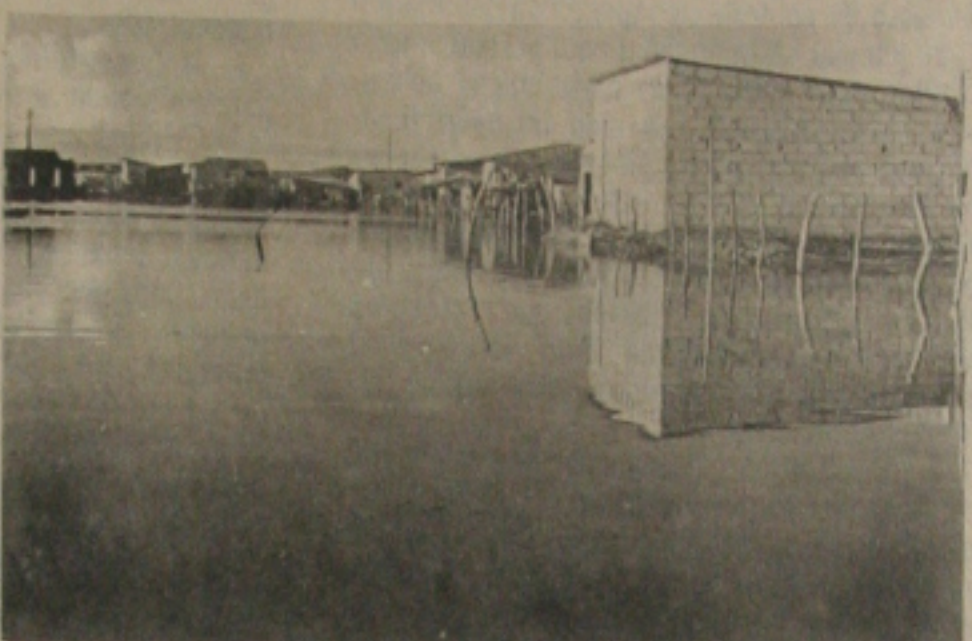
Na Atalala, ruas alagadas pela maré mais alta do ano.
