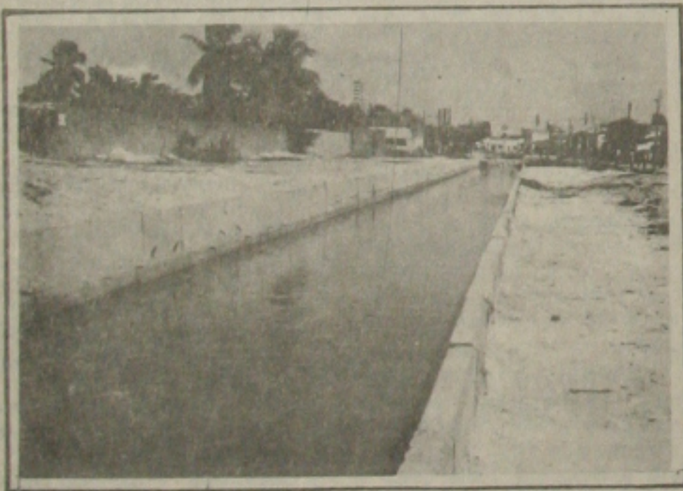
Canal Brasília está sendo revestido.
