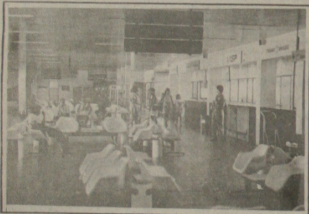
O novo terminal de passageiros terá dois pavimentos.
