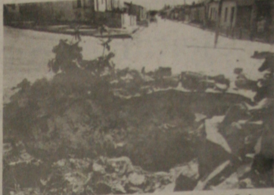
Moradores pleiteiam restauração de rua. (Foto Lutz Carlos Moreira)
