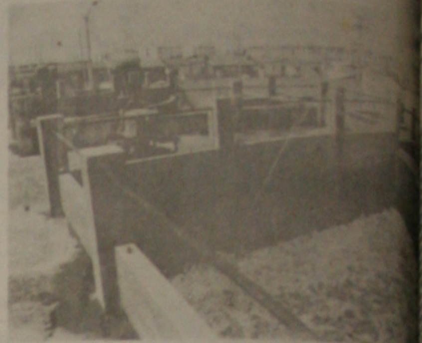
Estação de Tratamento de esgoto do Conj. Orlando Dantas (Foto Luiz Moreira)
