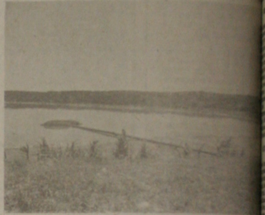
Lagoa de Tratamento de esgoto industrial provoca mal cheiro, diz projeto, envolvendo a CODISE pela administração do DIA, a ADEMA, e a DESO, para que apontasse alternativas de solução. Luciano Faro não conhece o teor do projeto, mas garantiu que dentro de 60 dias ele estará concluído e que se baseia fundamental na questão de que as indústrias devem ter as
