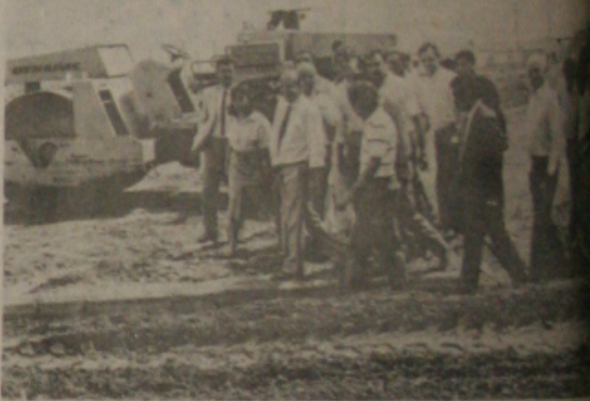
Valadares inspeciona obras do Conj. Eduardo Gomes em companhia dos prefeitos Viana de Assis, de Aracaju e Horácio Souza Lima, da cidade de São Cristóvão.
