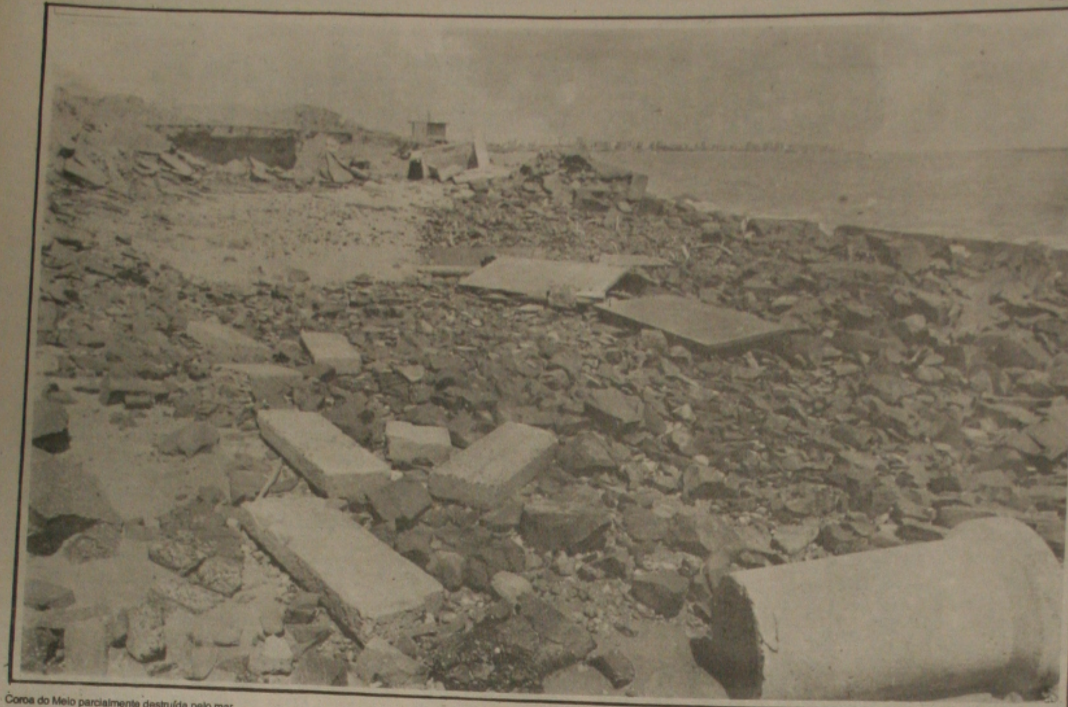
Coroa do Meio parcialmente destruída pelo mar
