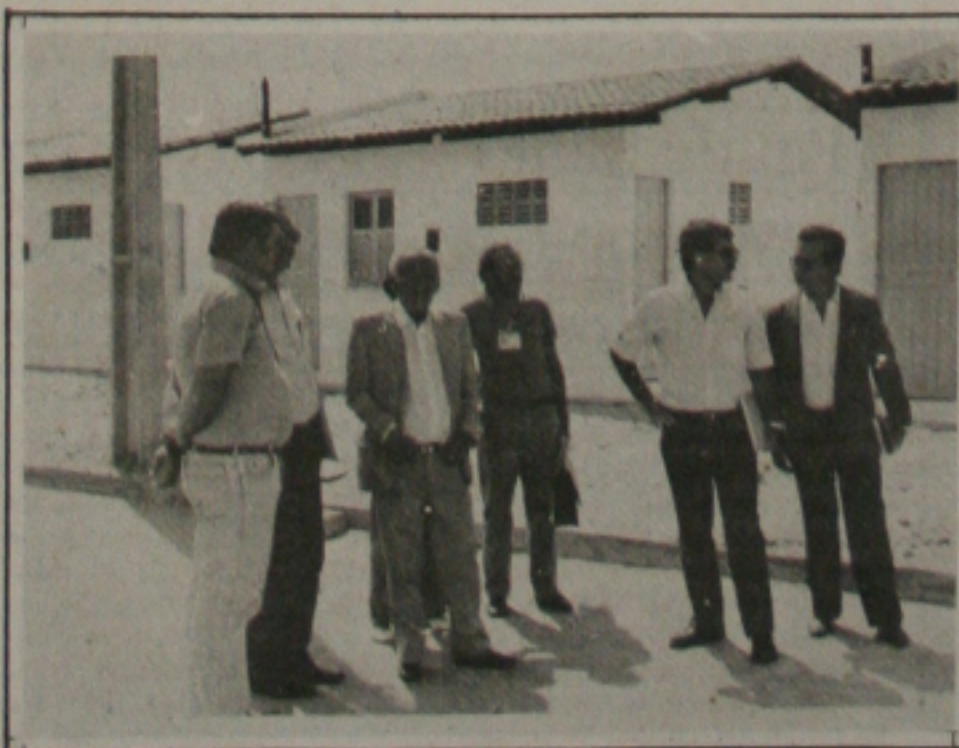
Secretário de Desenvolvimento Urbano, João Machado, visita obras de Conjunto habitacional.
