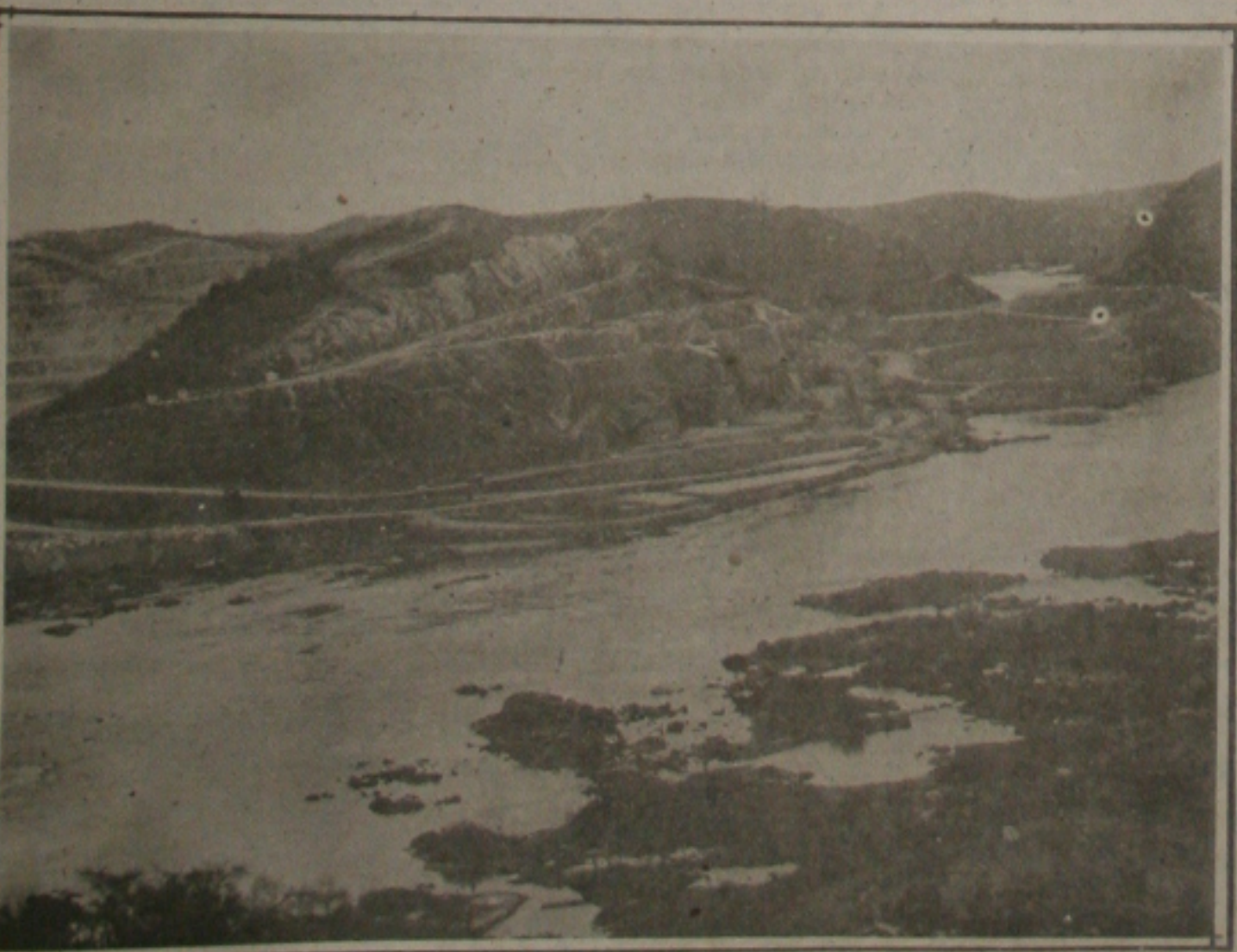
... O projeto continua em andamento.
