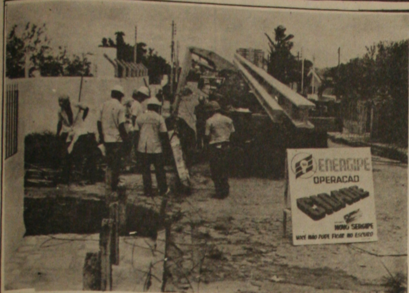
Operação Cidadã: trabalhadores da Energipe iniciam a recuperação da rede elétrica de Aracaju.
