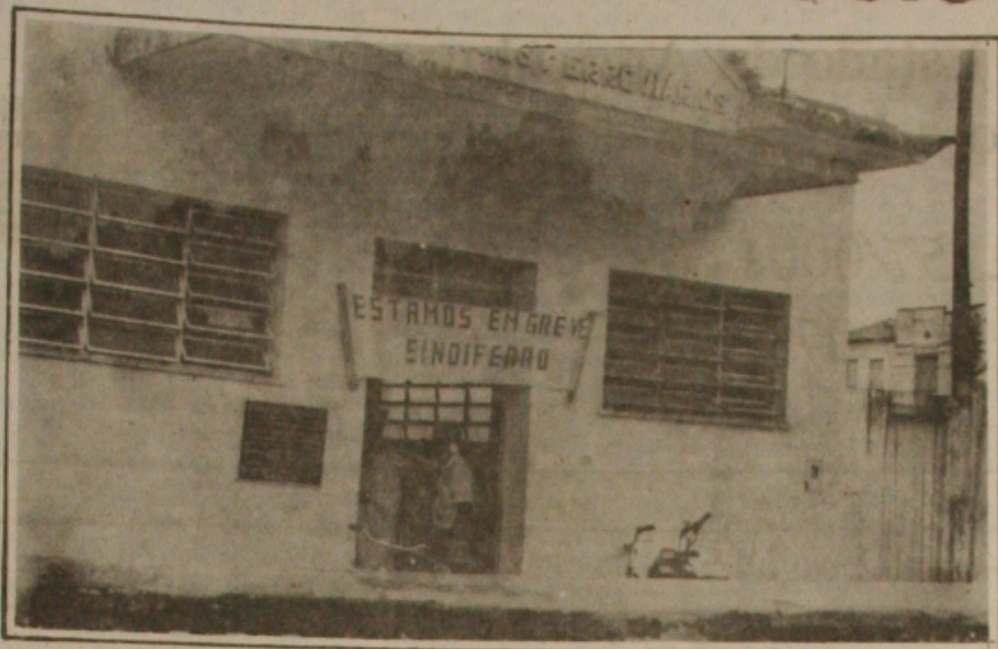
Com a faixa colocada na entrada da Estação, os ferroviários anunciam a greve geral da categoria.
