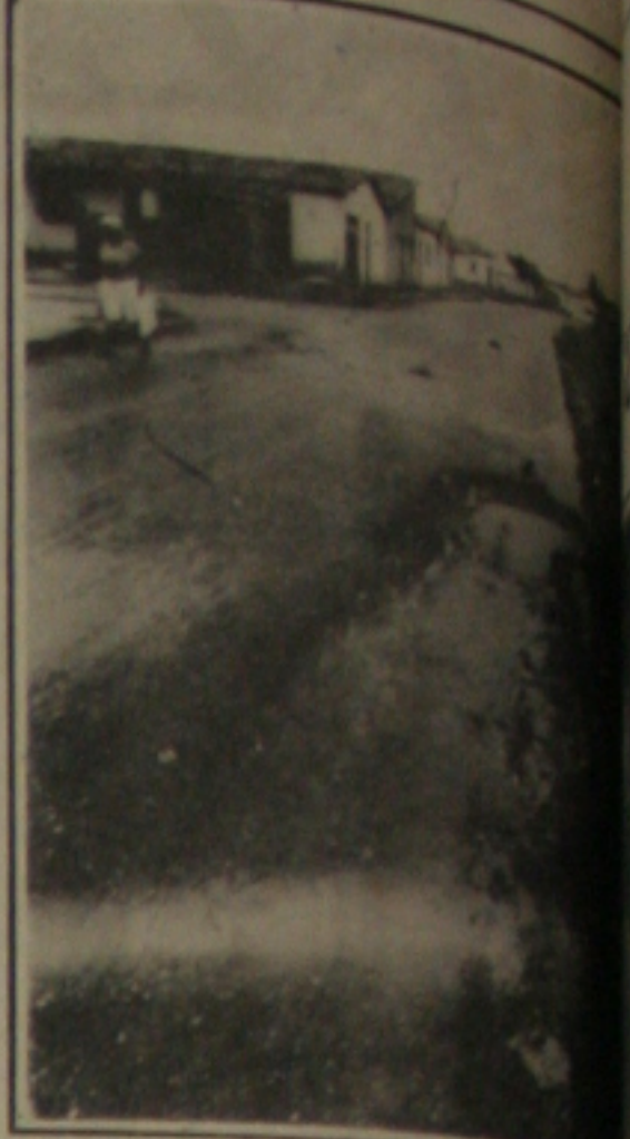
Chuvas provocam erosão danificando o asfalto no Galvão Gomes.
