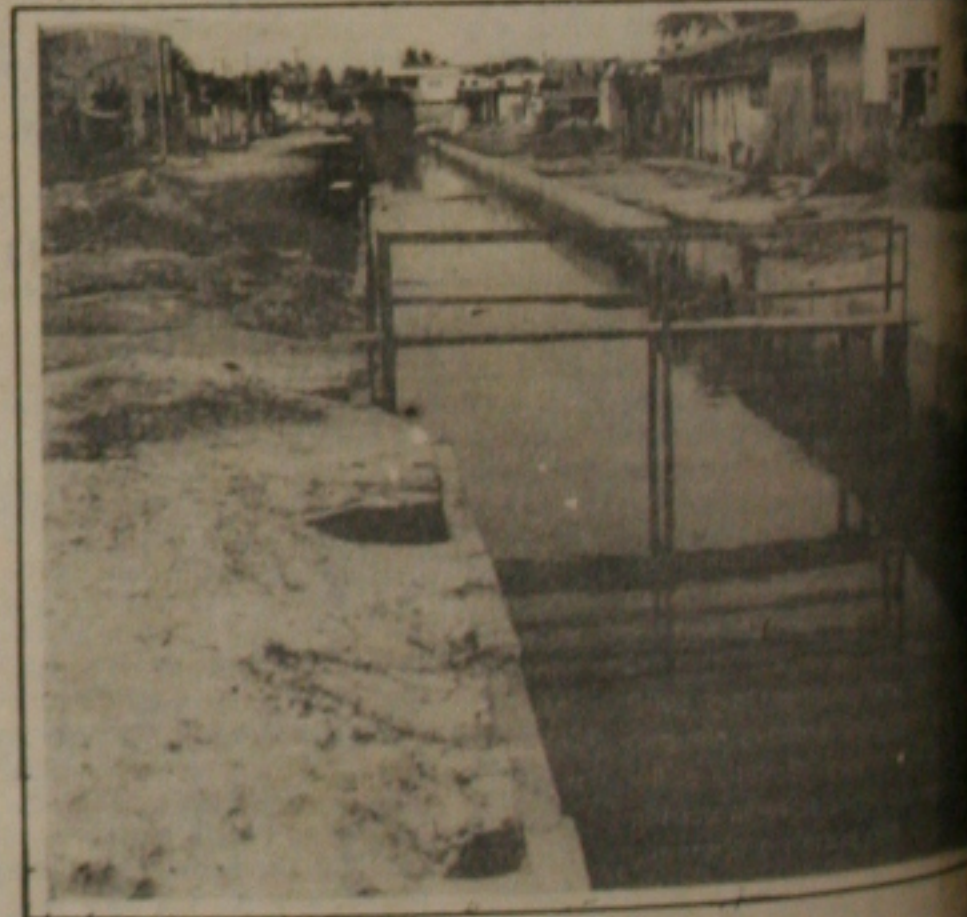
Moradores querem conclusão de obras em canal.
