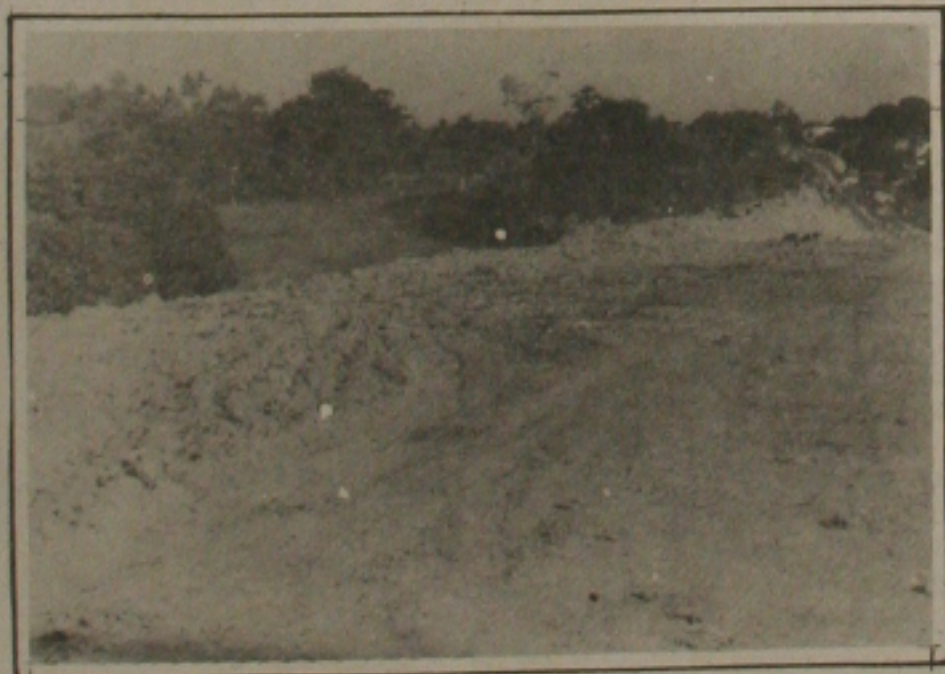
Retirada de barro causa prejuízos.
