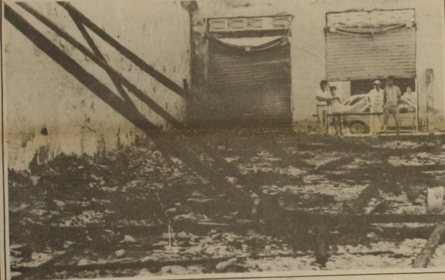
Incêndio: destruição total das instalações e dos móveis e eletrodomésticos.
