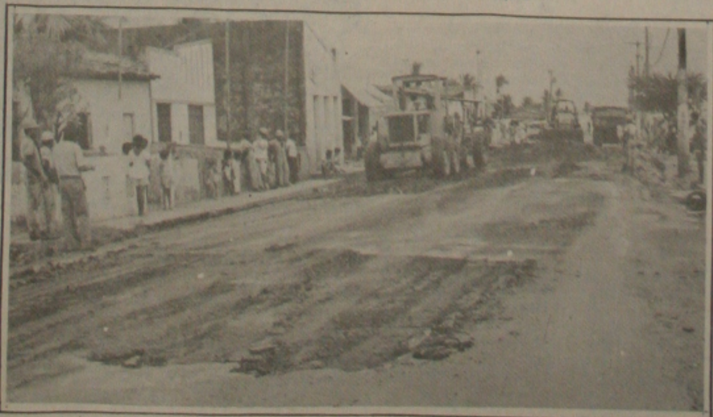
Prefeitura começa recuperar ruas destruídas pelas chuvas.
