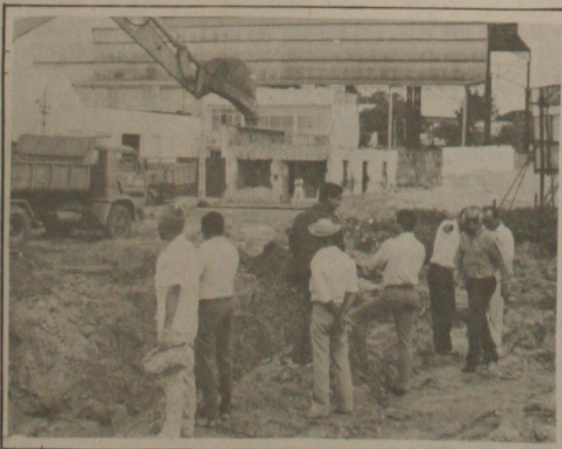
Prefeito de Aracaju visita obras em companhia de assessores.
