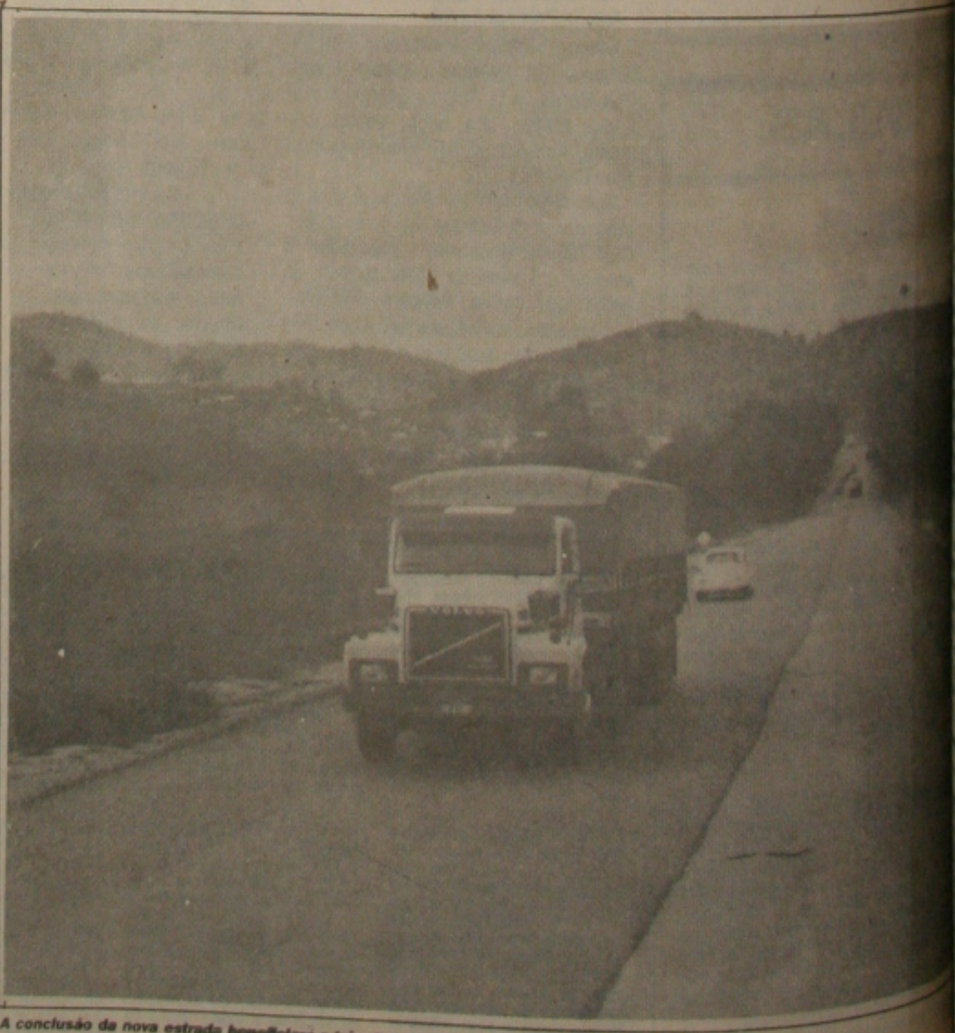
A conclusão da nova estrada beneficiará o trânsito na BR-116 (Rio-Bahia)
