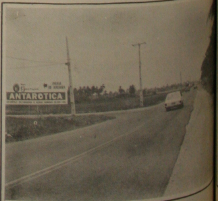
Rodovia dos Náufragos é totalmente recuperada pela Emurb.
