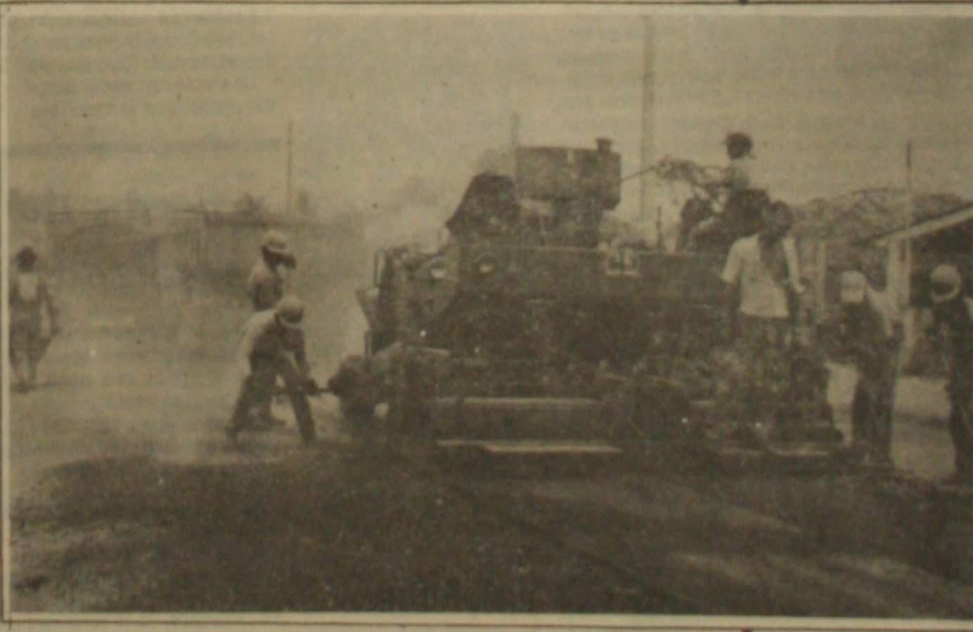
A Emurb está recuperando a pavimentação asfáltica do centro da cidade. (Foto - Lindvaldo Ribeiro).
