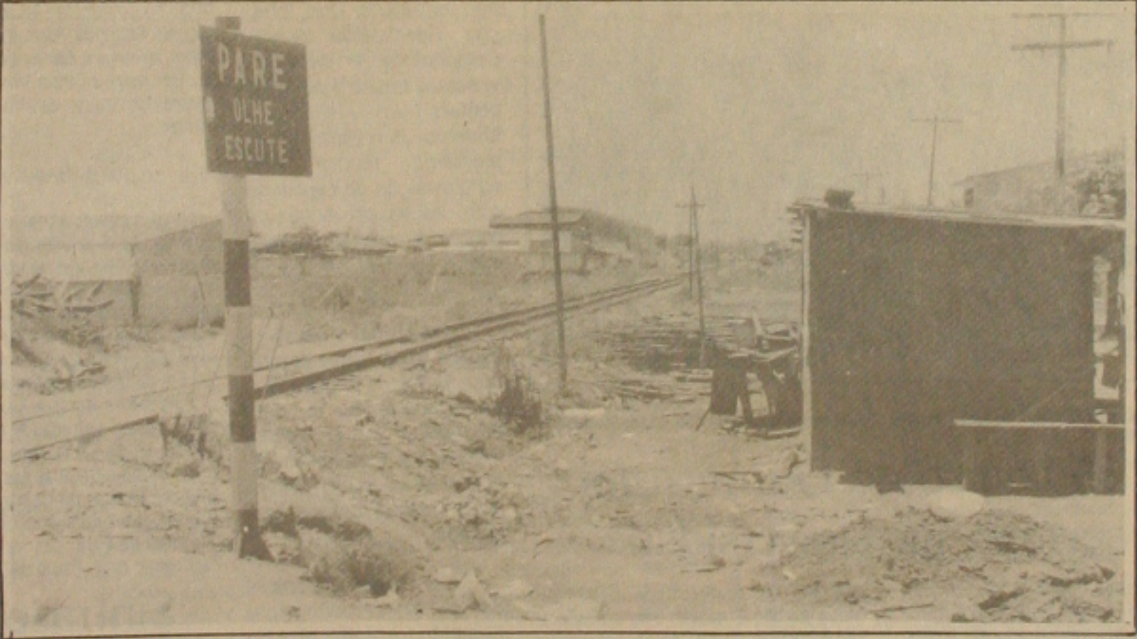
Avenida São Paulo transformada em lixeira e esburacada pela empresa que construiu o canal.
