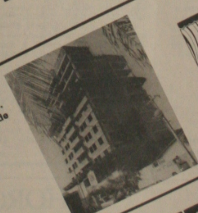
Foto da Obra
