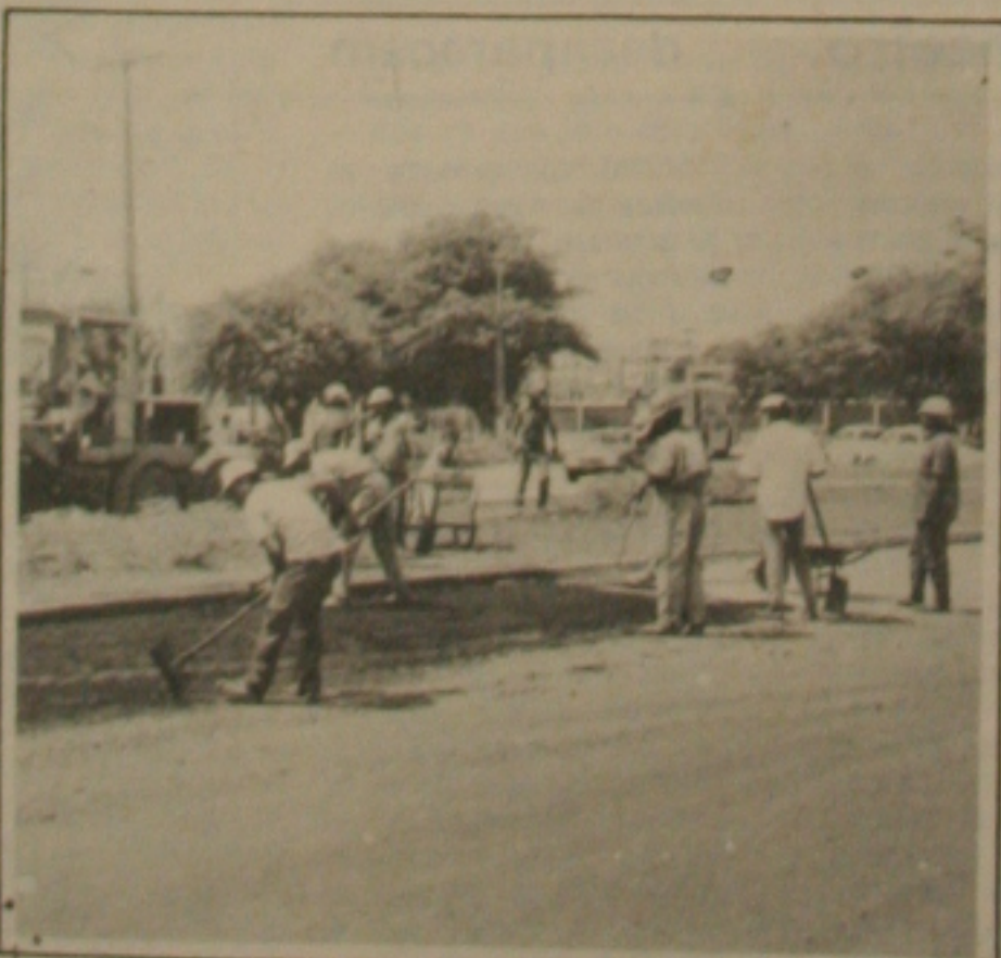
Emurb promove operação "tapa-buraco" em avenidas e ruas.
