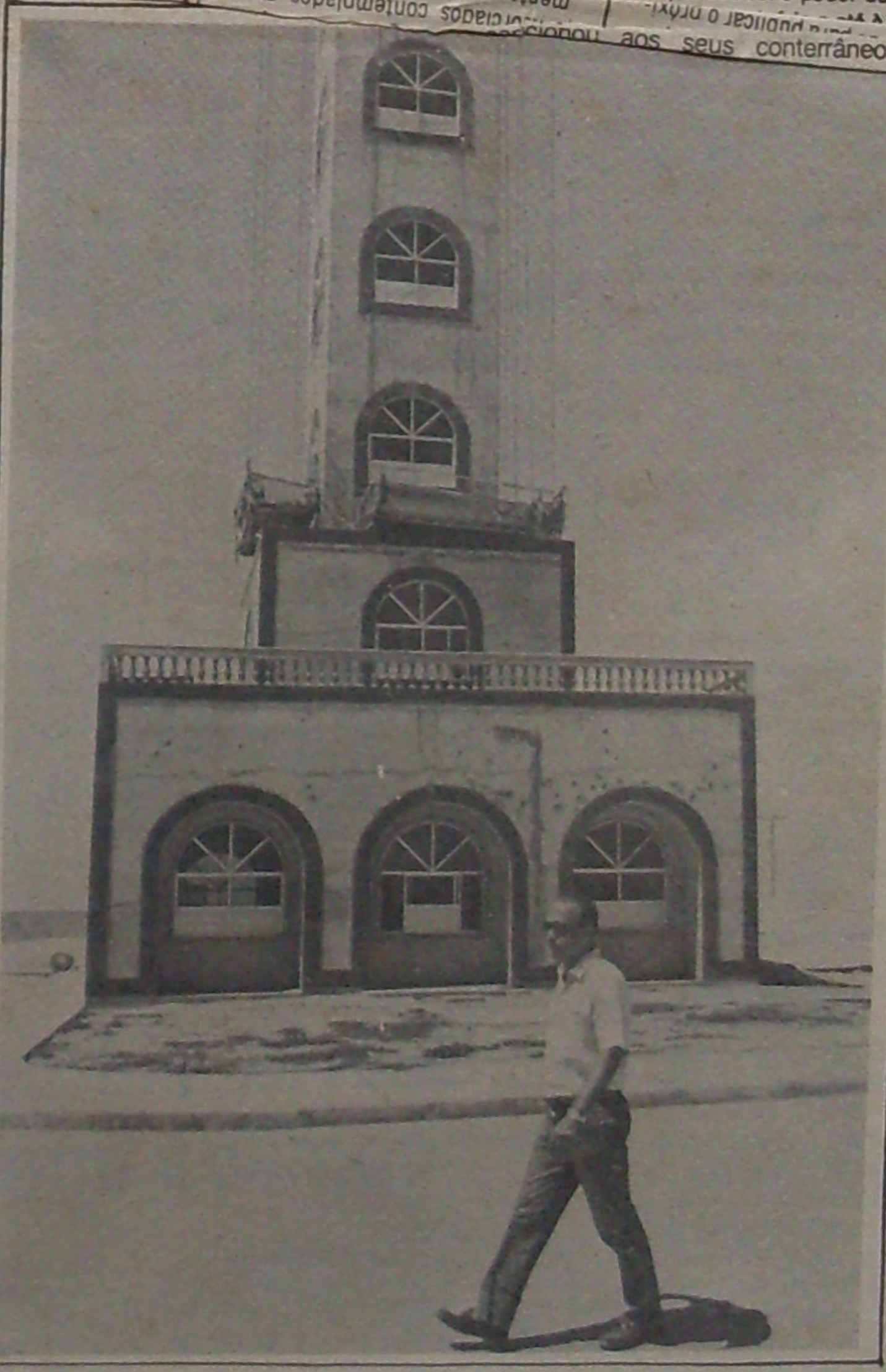
Valadares visita o novo Farol de Aracaju, em construção na Coroa do Melo.
