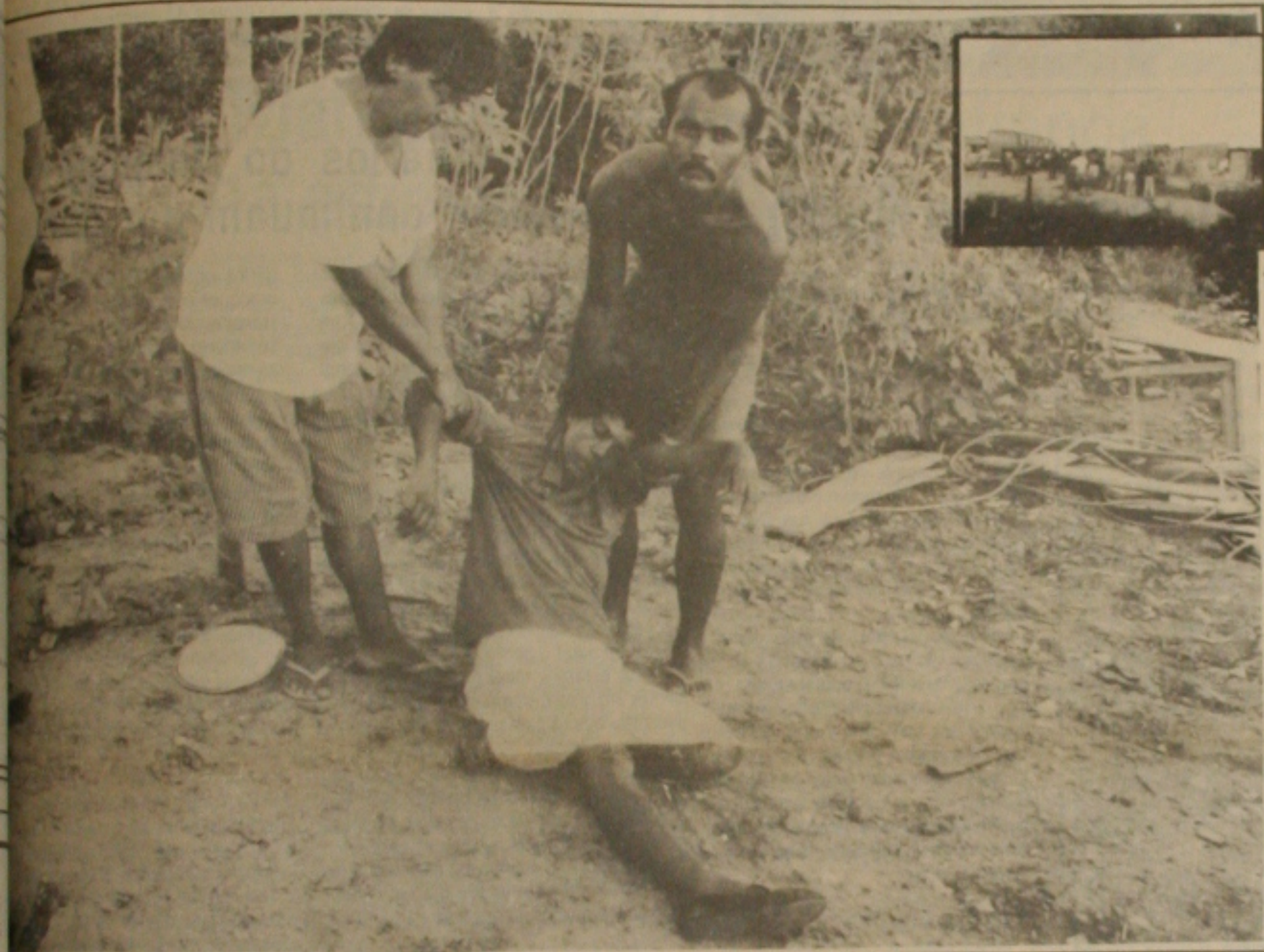
Um morador não resiste e desmaia ao assistir a demolição do seu barraco. No destaque, flagrante de uma casa construída pelos policiais. Foto: Fernando Silva.
