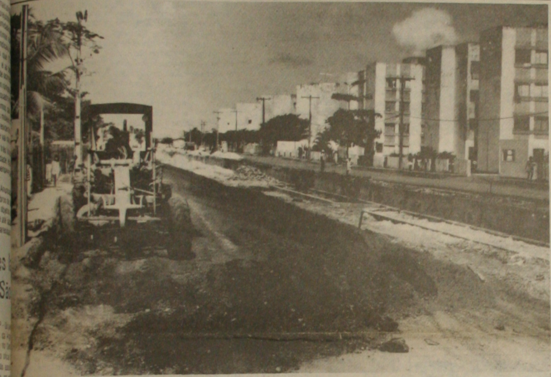
Trabalha obras de pavimentação na Av. Francisco Moreira. (Foto Walter Martins)
