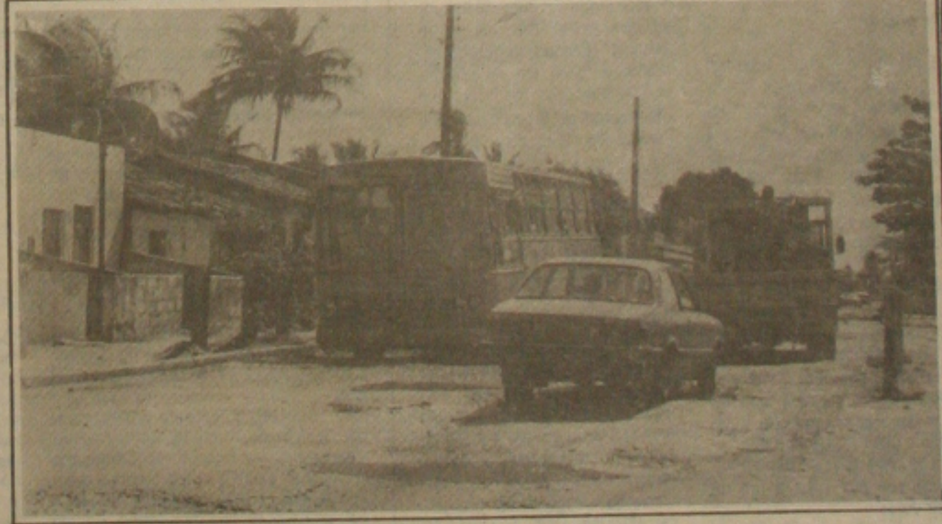
Com as ruas esburacadas, fica difícil para os ônibus a circulação pelo anel viário da cidade.
