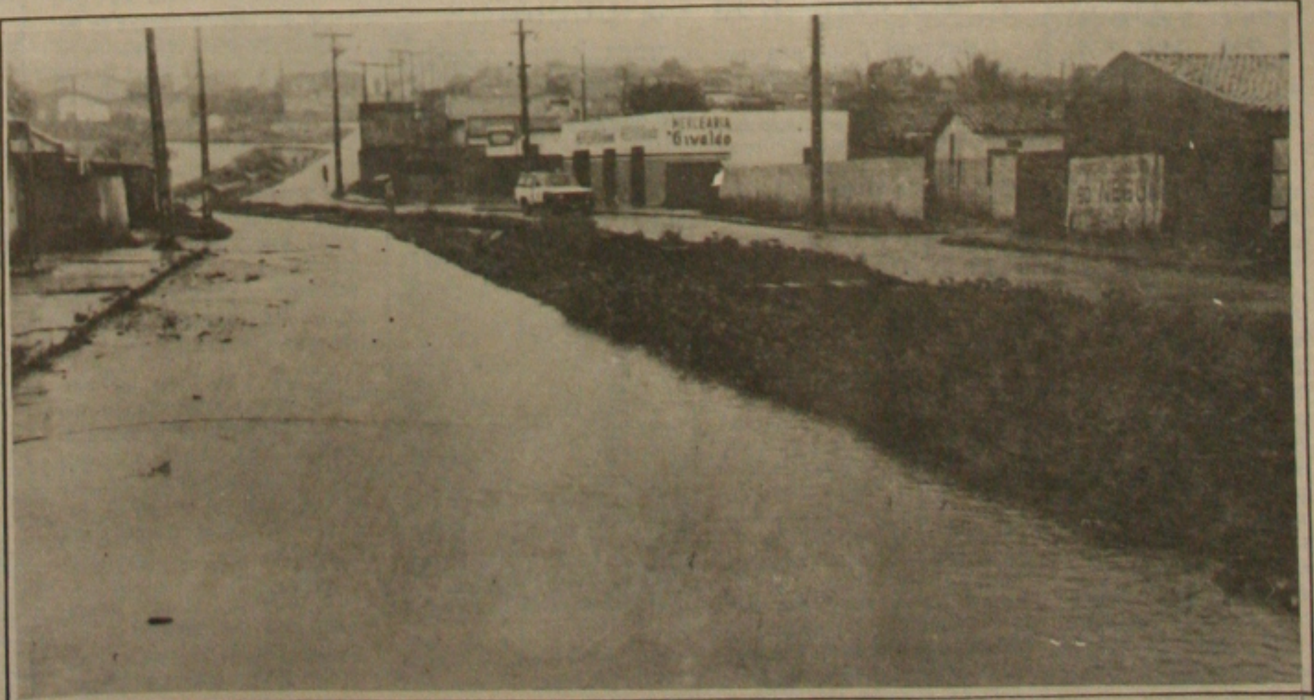
Chuvas alagam ruas e avenidas de Aracaju. (Foto/Arquivo)
