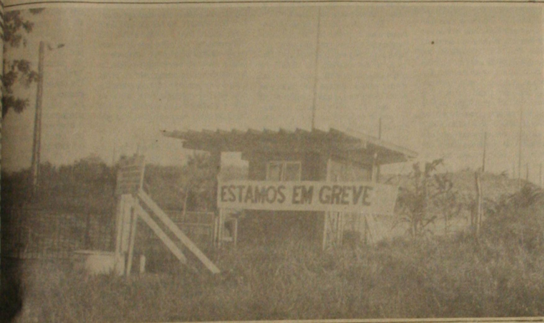
Os eletricitários, as subestações da Chesf em Sergipe estão sendo operadas por engenheiros e chefes de departamentos.
