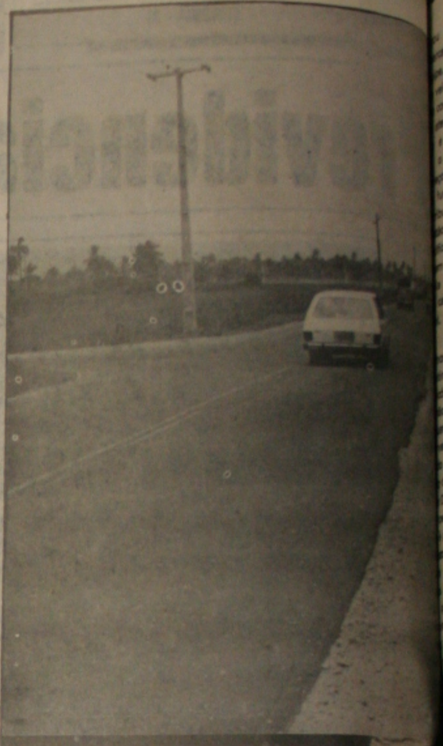
A rodovia Camilo Calazans também
