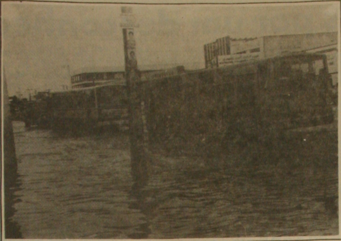
A chuva que caiu ontem a partir do meio dia, deixou várias ruas completamente intransitáveis.
