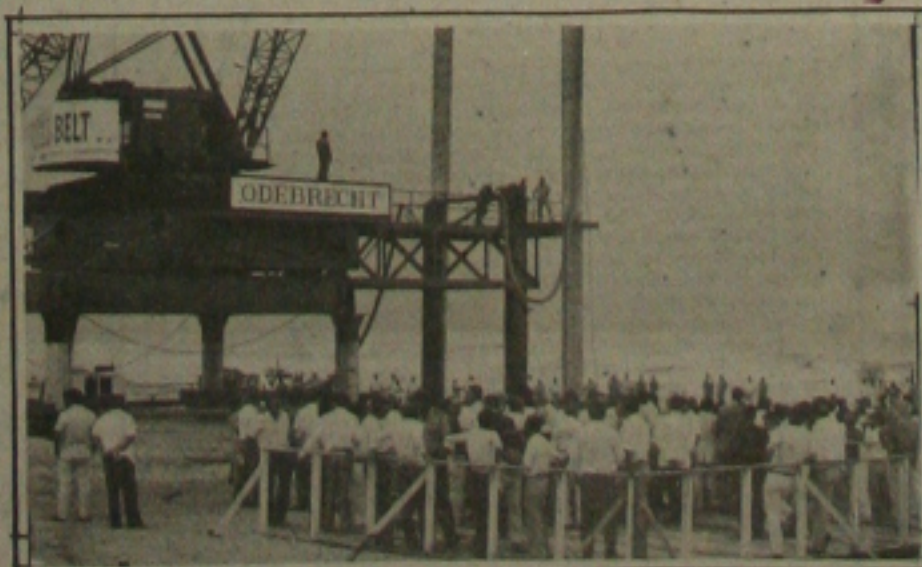
A Odebrecht disse que faltou dinheiro para continuar as obras.
