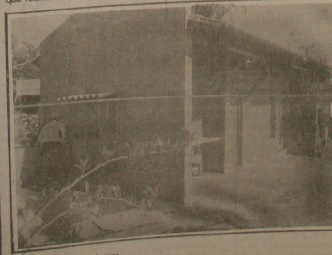
Sanitários destruídos por vândalos
