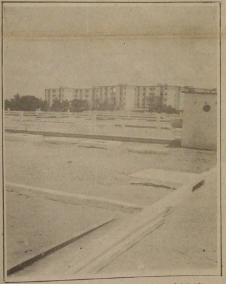
Aspecto da Subestação do Urubu, que terá suas obras civis inaugurada hoje pelo governador Valadares. (Página 1B).
